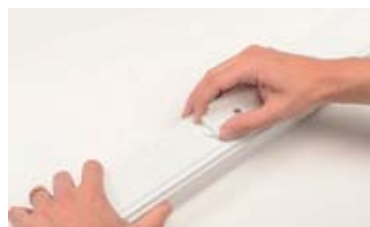
5 - verrouillage de la platine
