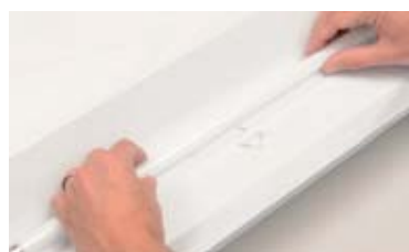
8 - installation de la lampe
