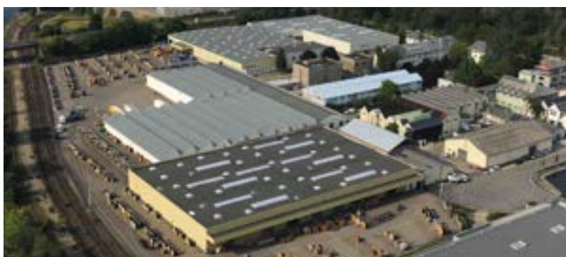
Le centre logistique SERMES câbles à Strasbourg Port du Rhin
