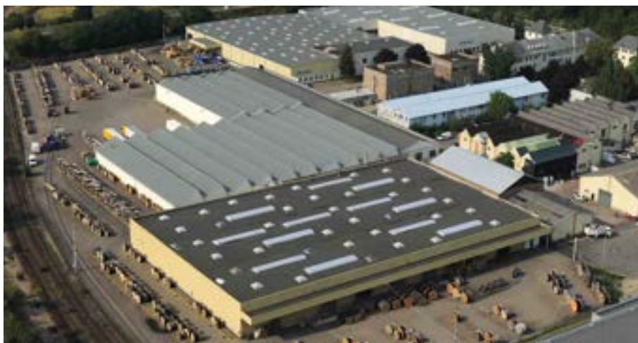
Le centre logistique SERMES câbles à Strasbourg Port du Rhin
